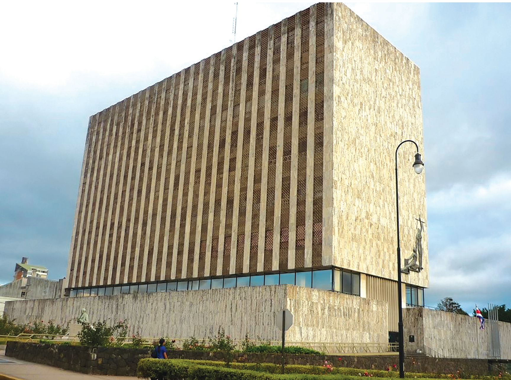
Edificio Corte Suprema de Justicia. Las fachadas laterales con orientación norte y sur, poseen una trama conformada por un ritmo alterno de paramentos o lienzos de muro con un tamiz de paneles perforados de aluminio anodizado importado de Venezuela que permite la ventilación cruzada y el aprovechamiento de la iluminación natural. F130
