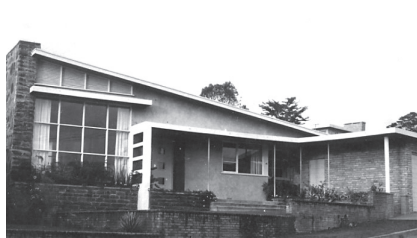
Casa Alfonso Maroto avenida 8 entre calles 39 y 41. Barrio Los Yoses F87
