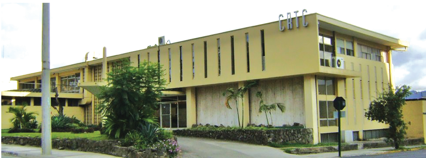
El edificio original, posee algunas invariantes de la influencia moderna, el uso de la planta libre, la estructura de soporte independiente de los cerramientos, el uso de cubiertas laminares. Existe una estrecha relación entre el espacio interno, permeable a través de balcones, y el espacio externo que toma como elemento conformador del conjunto edificado, el área de la piscina y los jardines de la época. F105
