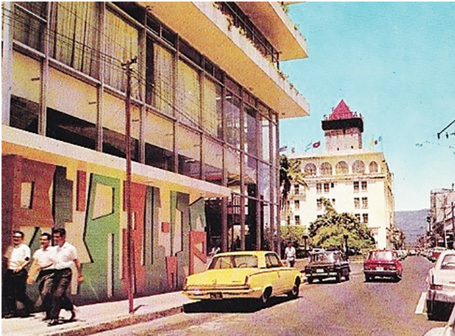
Edificio del antiguo Banco Anglo (1963), fachada este. Arq. Jorge Escalante F28
