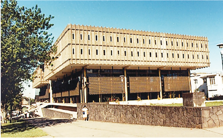
El edificio fue construido por la empresa constructora CARREZ S.A. en el periodo 1969- 1971, año de su inauguración. Está cimentado sobre pilotes de concreto armado, posee entrepisos pretensados construidos con el sistema reticular celular. F149
