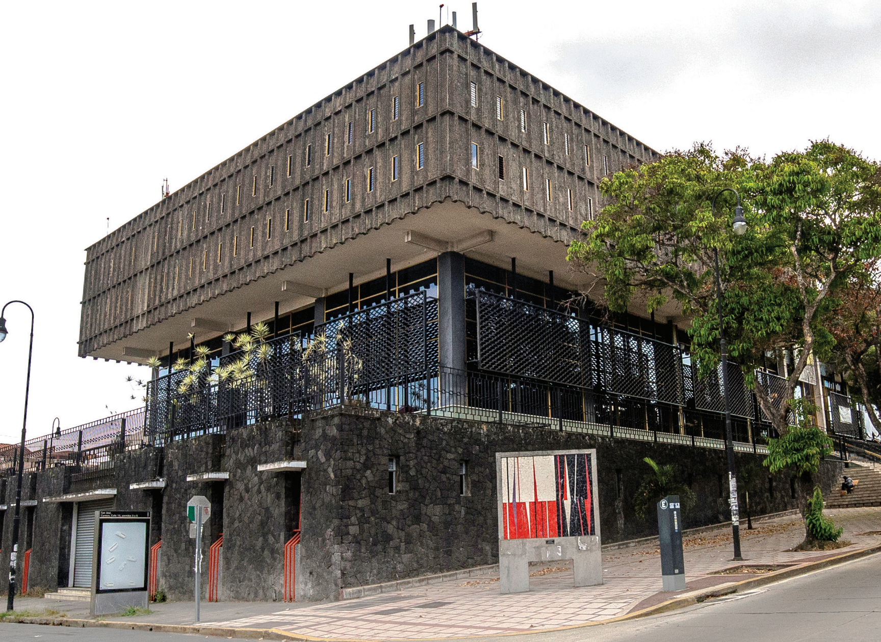
Parasoles de aluminio color negro crean un efecto de tamiz en la fachada principal de la Biblioteca Nacional, que tiene orientación sur y en sus fachadas laterales, con orientación este y oeste. El anodizado llegó a ser un proceso muy apreciado por su resistencia a la corrosión y la capacidad de mantener su aspecto original. F148
