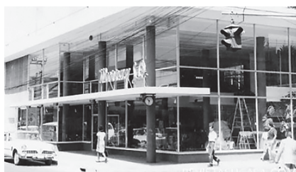
Edificio Erick C. Murray, avenida 1, calle 7, San José (1957) F84
